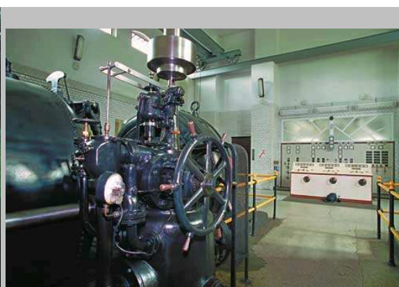
Zdjęcie 7. Elektrownia Straszyn
