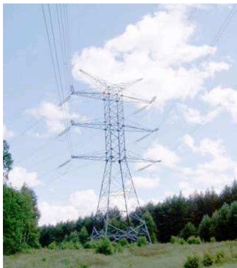
Zdjęcie 12. Linia wysokiego napięcia w Gminie Kolbudy
